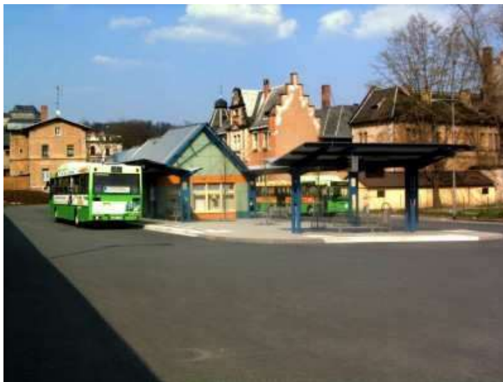
Greiz, neuer Busbahnhof
