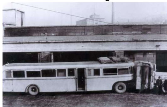
Der „lange Thüringer“ mit Holzvergaser
